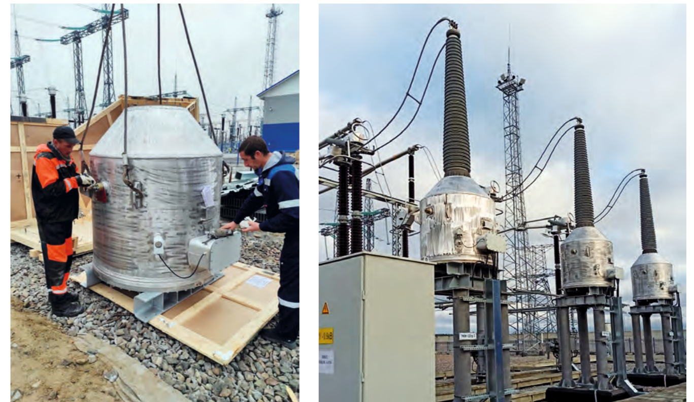
Рис. 3. Установка и подготовка к работе ТНБМ ЗНГ-УЭТМ®-330 (200) на РП Каменный Бор
