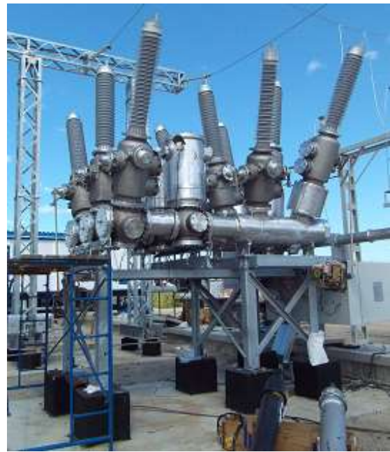
Рисунок 14 – РУЭН-УЭТМ ® -110 на ПС Намыв, Якутия.
