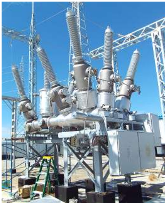
Рисунок 14 – РУЭН-УЭТМ ® -110 на ПС Намыв, Якутия.
